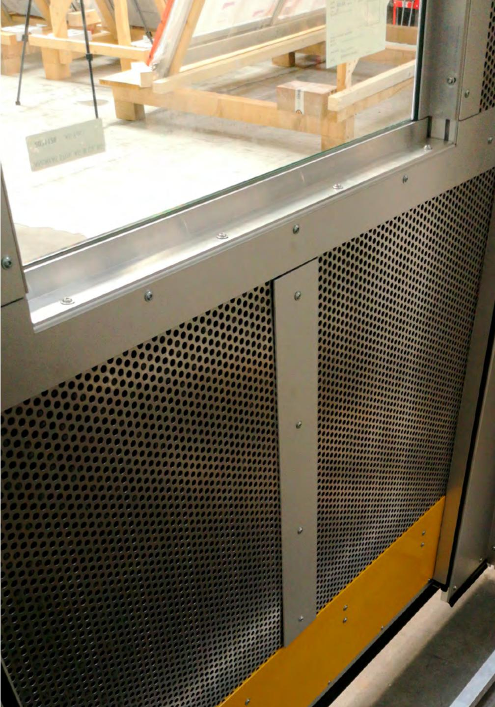
Schallschutz mittels Terodem-Platten und Lochblech (Rückansicht)
